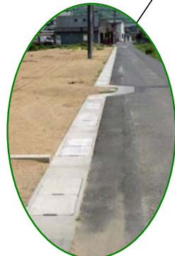
危険な側溝へ蓋を設置（西郷）
