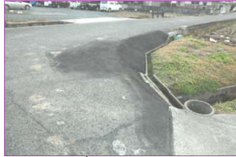
崩れがちな法面の補修（西郷）
