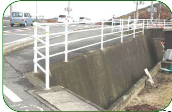
危険個所にガードパイプを設置（東郷）
