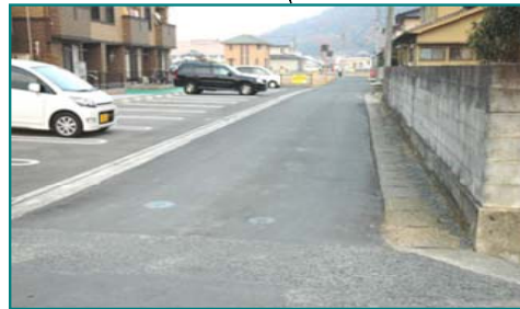
路面が大変傷んでいたため再舗装（東郷）
